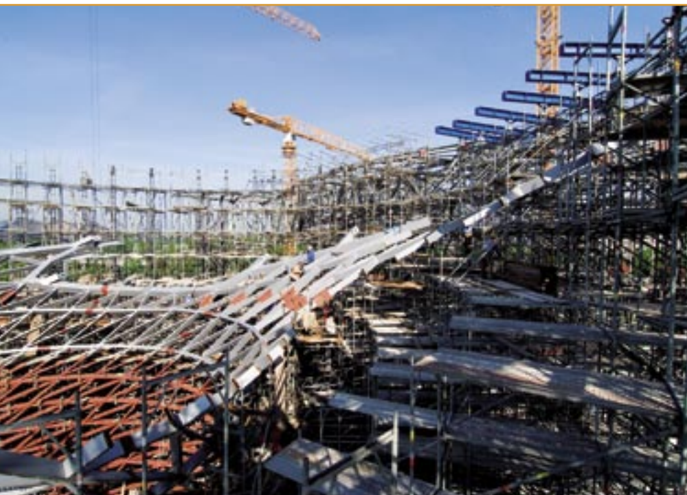
Ein gigantisches Traggerüst aus Laststützen und rund 35 000 m 2 Rahmengerüst hält das künftige Wahrzeichen der neuen "BMW-Welt" in Form.
